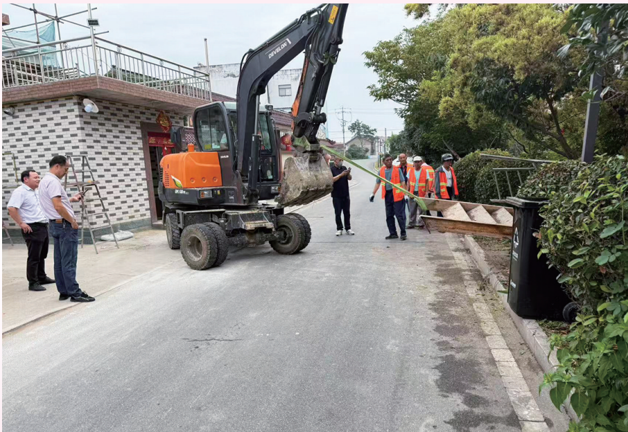
近日,市水利综合服务中心给排水管理所联合开发区水利分局、海沃润扬环境有限公司及属地村委会,对老横泾河花王村一组河道侵占、违规搭建码头问题开展集中整治,依法拆除违建码头,彻底清除河道侵占。图为整治现场。 邮水轩 郭萌 摄影报道
