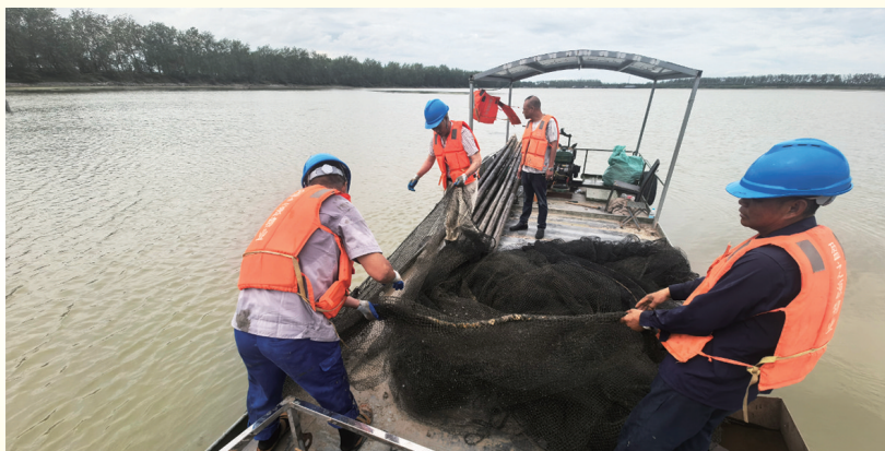
近日,京杭运河管理处开展运河全线水上巡查,及时发现并处置清水潭水源地二级保护区内违规设置的障碍物,共清除连片拦河鱼簖约100平方米。图为清理现场。 杨小光 郭萌 摄影报道
