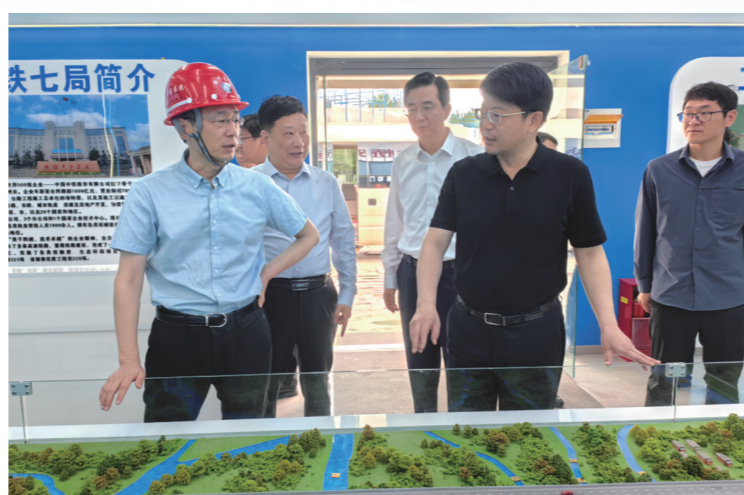
市领导调研宁盐高速高邮湖特大桥建设
