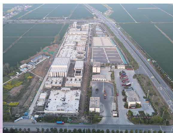
污水处理厂即将竣工
