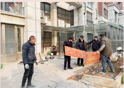
城管队员拆除新增违法建设
