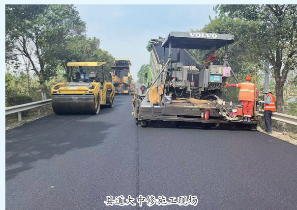
县道大中修施工现场
