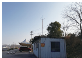
运河船闸石工头有私搭乱建集装箱房且有小广告乱张贴
