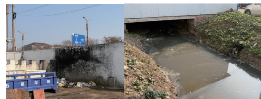
高邮湖路好客超市门前河道黑臭,对院内垃圾乱堆放、墙面脏污严重
