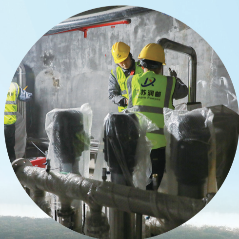
增压设备安装
