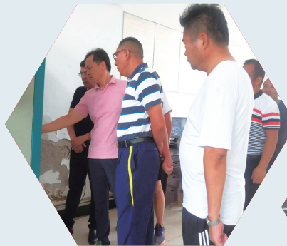
现场协调解决车逻辑供水问题
