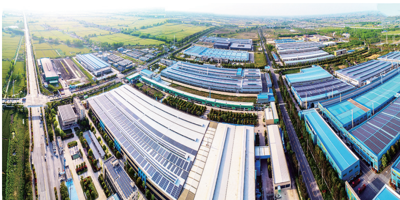
为进一步放大高邮电池工业园产业集聚效应,提高项目科技含量,近年来,开发区先后与哈尔滨工业大学、大连理工大学等高校院所达成合作协议,筹建了储能研究院、省级电池产品检测中心,切实做到环保达标百姓放心、平台引智企业省心。图为电池园俯瞰画面。 朕宇 王林山 摄影报道
