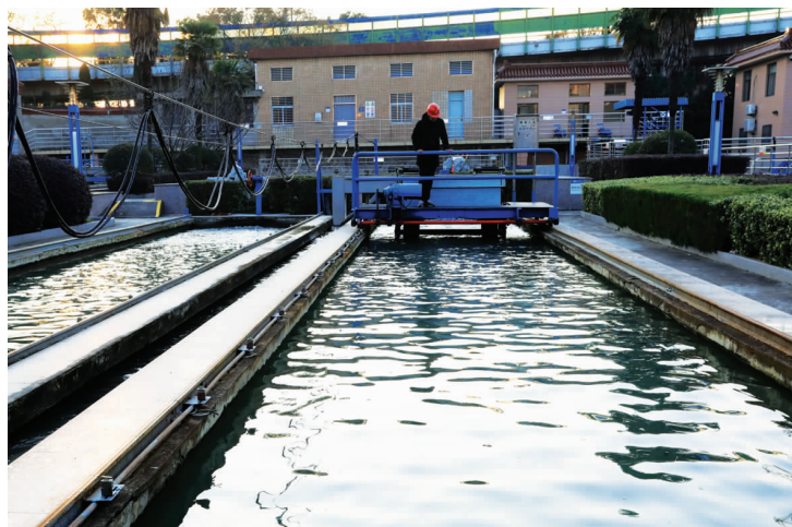
港邮供水有限公司的二水厂至一水厂清水管线工程,已于2018年12月底正式完工。该工程验收后将正式对外供水,有效保证了出厂水的水质,从而提高居民的用水标准,实现从合格水向优质水的转变。图为一水厂工作人员正在检查水质。 王林山 摄
