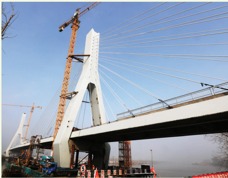
界首运河大桥主桥合龙后,施工人员加紧铺设桥面道路,并对桥身进行装饰,对周边环境进行绿化亮化,预计大桥将于今年 4 月完工并通车。图为大桥雄姿。 王林山 摄
