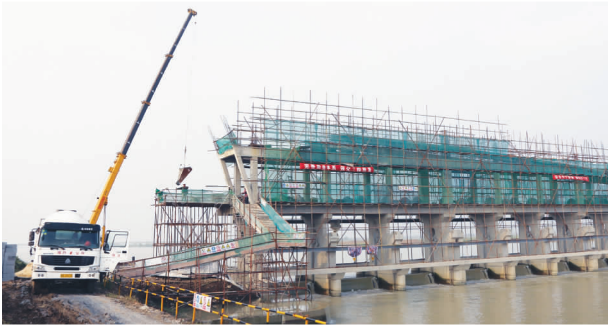
高邮湖新港漫水闸除险加固工程是淮河水道整治工程中的重要内容,该闸对于调控高邮湖水位,发挥高邮湖灌溉、航运、生态保持等功能具有十分重要的作用。目前该工程正在建设之中,预计年底完工。图为正在建设中的新港漫水闸。 王林山 摄
