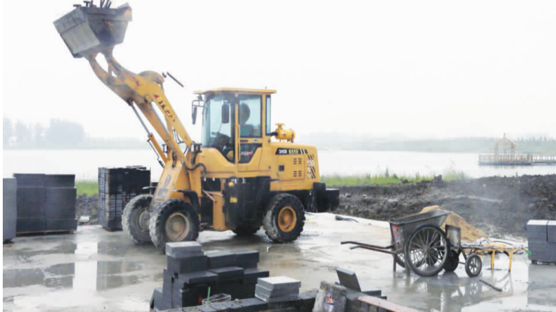
位于开发区总投资19亿元的大运河生态文化旅游度假区一期工程已进入全面建设之中,预计2017年可建成滨湖餐厅、大马戏场、儿童乐园、文博区、大运小镇等。图为施工单位进场施工的场景。 王林山 摄
