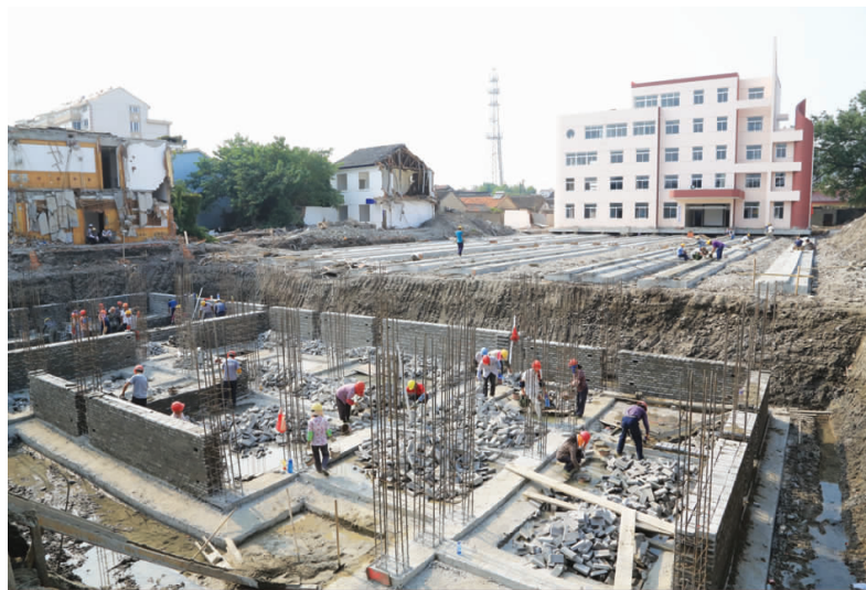
为纪念抗战胜利 70 周年,我市将在抗战最后一役纪念馆前兴建一处纪念广场,目前施工队正在紧张施工,预计工程将于今年 12 月 26 日前完成。 图为施工人员正在做对原老年大学教学楼整体平移准备工作。 王林山 摄
