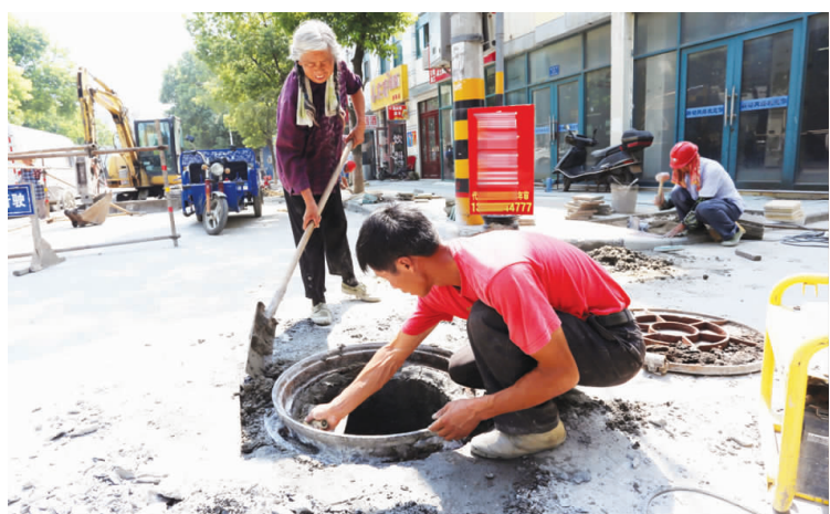
我市已连续几年实施后街后巷改造工程，今年又对老城区骨干道路实施污水管网建设、照明亮化和“三线”下地工程。图为近日施工人员在国雄路实施环境提升提质工程。 王林山 摄
