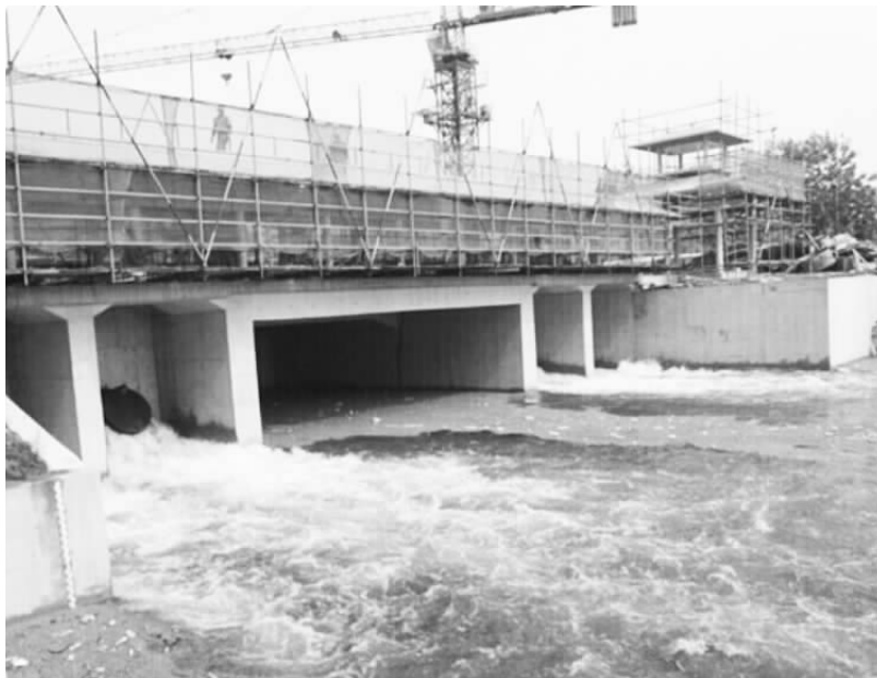
北澄子河闸站经过施工人员的紧张施工，日前顺利试机出水。随着四台水泵的正常运行，标志着北澄子河闸站具备了挡排能力，将提高城区防洪能力。据悉，整个北澄子河闸站工程将于 7 月底竣工。 玉梅 摄
