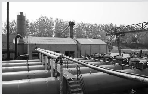
蒸压加气混凝土砌块生产
