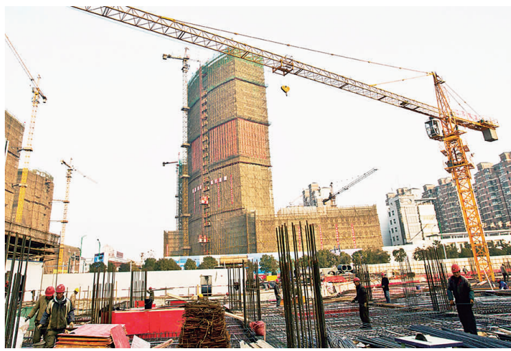
由波司登公司投资25亿元的世贸广场项目,目前24层大型超市及总部商务办公中心已封顶。预计年底,世贸广场购物中心、苏果超市等可对外营业。图为正在建设中的世贸广场一角。 王林山/摄
