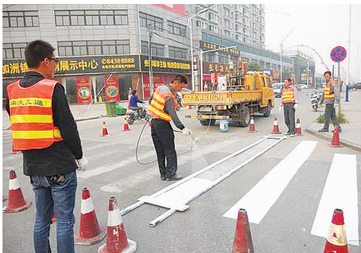
为提升城市道路通行能力,以优美的城市形象迎接第六届中国邮文化节的举办,市相关部门以环境综合整治和“三拆三整治”为契机,对市区相关路段路面交通标志进行美化出新。图为工人正在泰北路划斑马线。 尹宏武 王云 摄
