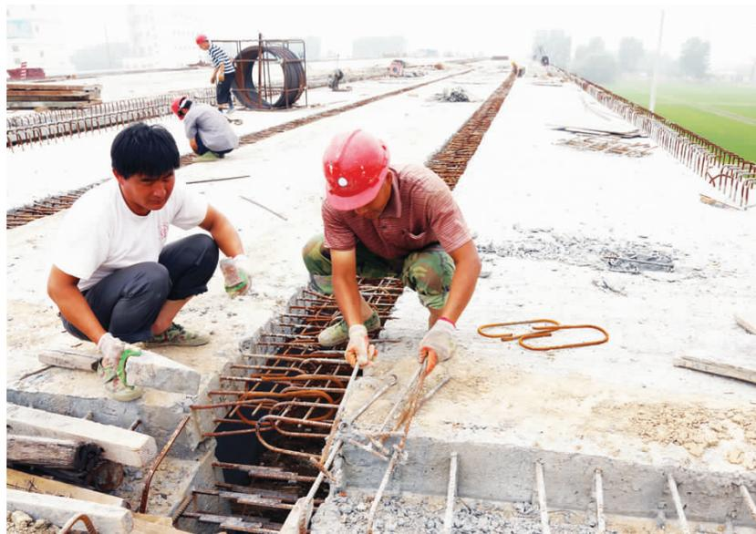
全长42.9公里的237省道高邮段一期改建工程通车后,市交通局又迅速启动了二、三期道路扩容改造工程。目前,二期工程已进入扫尾阶段,预计今年10月可通车。图为施工人员在为北澄子河大桥桥面沥青摊铺做准备。 王林山 摄
