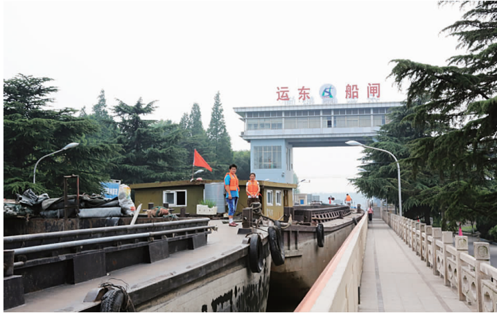
近日记者在运东船闸采访时看到,排队过闸的船舶为众多。为缓解船舶过闸压力,运东船闸狠抓现场管理,实行科学调度,以确保待闸船舶安全、快速通航。图为运东船闸工作人员引导船只过闸的场景。 王林山 摄
