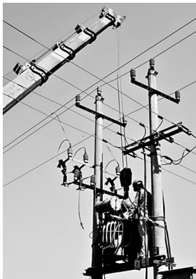
根据辖区内工农业生产以及夏季用电高峰实际需求，近日，周巷镇供电所组织专业人员，对 4 台满负荷运行的变压器进行调换，以确保正常供电和用电安全。图为工作人员在安装变压器。 孙进 朱炳能 摄
