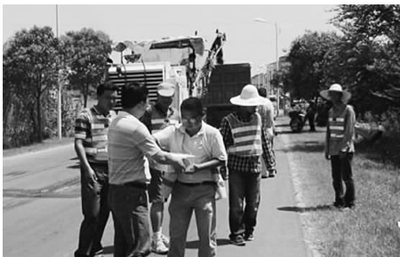
日前，市公路管理站领导班子及工会代表深入一线，为施工人员送去清凉饮料和慰问金，并叮嘱工区及项目负责人要注意职工身体健康，确保夏季安全生产。 王进 跃华 玉梅 摄
