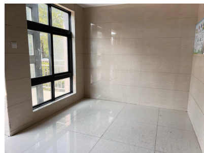
银河湾小区整改后
