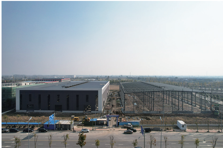
项目建设现场
