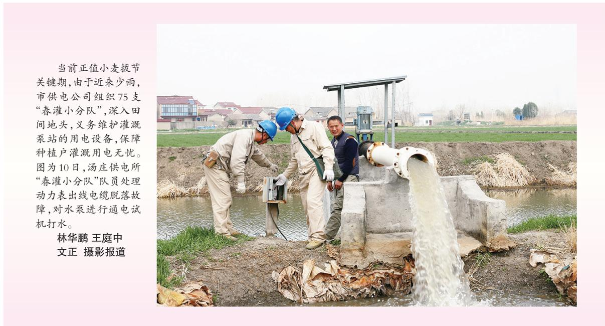
当前正值小麦拔节关键期,由于近来少雨,市供电公司组织75支“春灌小分队”,深入田间地头,义务维护灌溉泵站的用电设备,保障种植户灌溉用电无忧。图为10日,汤庄供电所“春灌小分队”队员处理动力表出线电缆脱落故障,对水泵进行通电试机打水。
