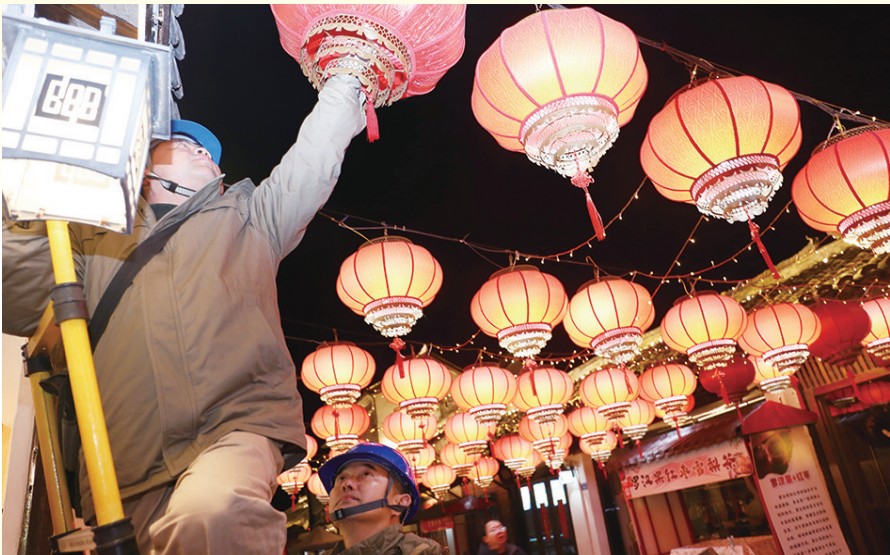
8日,市供电公司组织员工前往孟城驿景区维护景观灯,保障元宵节期间景区安全用电,方便游人观赏夜景。 林华鹏 俞小军 文正 摄影报道
