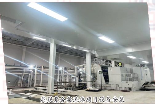
美联复合流体项目设备安装
