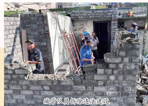
城管队员拆除违法建设
