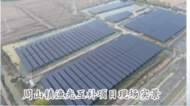
周山镇渔光互补项目现场实景
