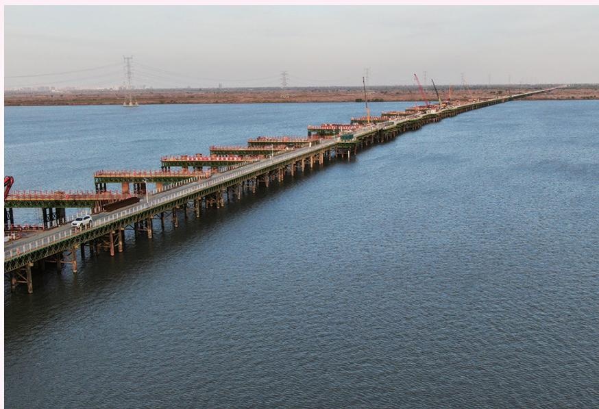
经过234天施工作业,近日,宁盐高速公路扬州段高邮湖特大桥钢栈桥全线贯通。据了解,该桥钢栈桥长6954米,桥面净宽8米,采用装配式结构,下部结构由直径630毫米、壁厚8毫米的钢管与2140工字钢及4组321型贝雷架组成。
