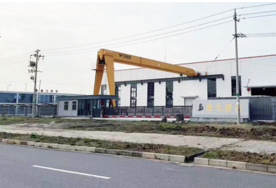
鑫元桥梁钢结构制造项目
