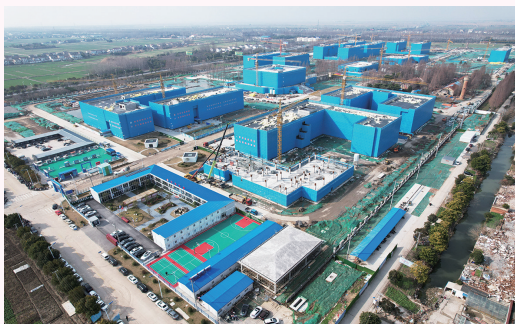
扬州职大高邮校区项目鼓足干劲,开足马力,加快项目建设,力争项目早日竣工。图为项目施工现场。
