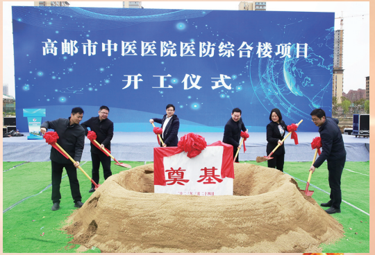
2023年民生实事中医医院医防综合楼正式开工。
