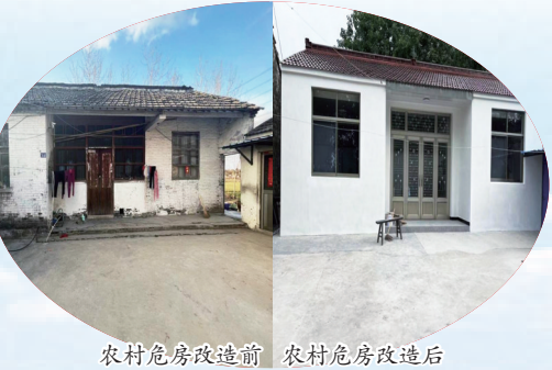
农村危房改造前 农村危房改造后
