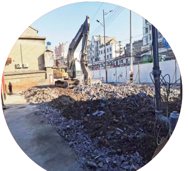
通湖路北侧、金桥路西侧房屋征收拆除现场
