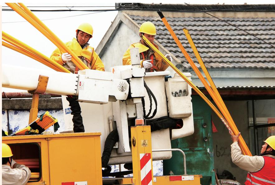
日前,市供电公司工作人员采取不停电作业方式,对龙虬镇东角村3根10千伏导线加装临时绝缘套管,保障安全可靠供电。图为作业现场。
