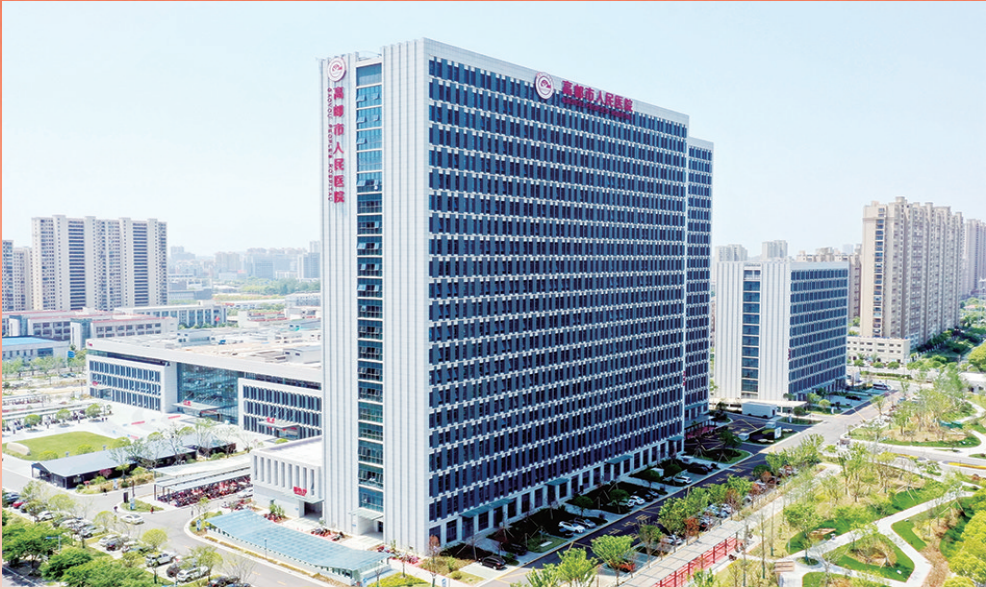
高邮市人民医院东区医院(二期)综合病房楼工程
