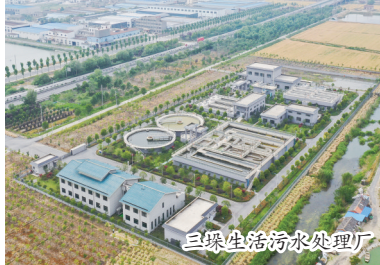
三垛生活污水处理厂
