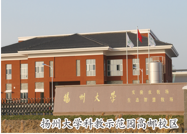
扬州大学科教示范园高邮校区
