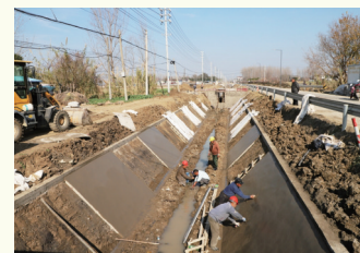
沟渠改造工程
