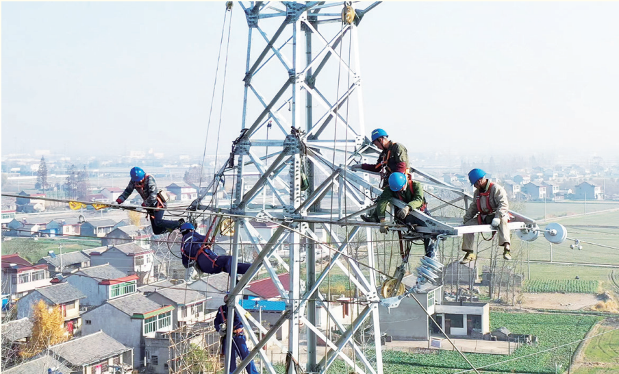
11月29日,市供电公司组织施工人员对10千伏界安线进行升级改造,以保障高邮芦苇荡湿地公园可靠供电。图为施工现场。 林华鹏 吴连来 文正 摄影报道
