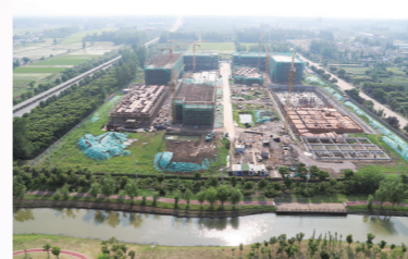
启迪项目现场
