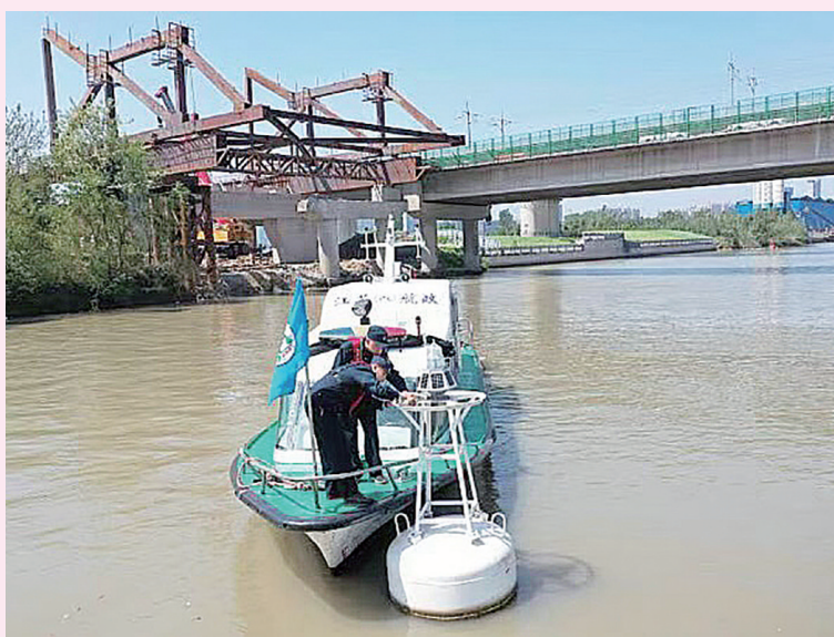
连日来,高邮航道站组织党员服务队,对通扬线航道高邮段8座在建桥梁区域通航情况进行专项排查,并协助施工单位对所有助航标志进行维护,确保航道畅通和施工安全。图为检查现场。 徐春景 葛维祥 摄影报道
