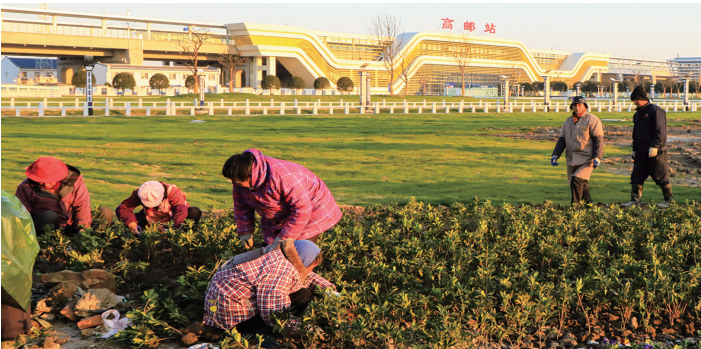
高邮高铁站是连淮扬镇铁路在我市境内设置的两个站点之一,目前高铁站已经做好迎客准备。图为施工人员进行外围相关完善工作。 王林山 摄
