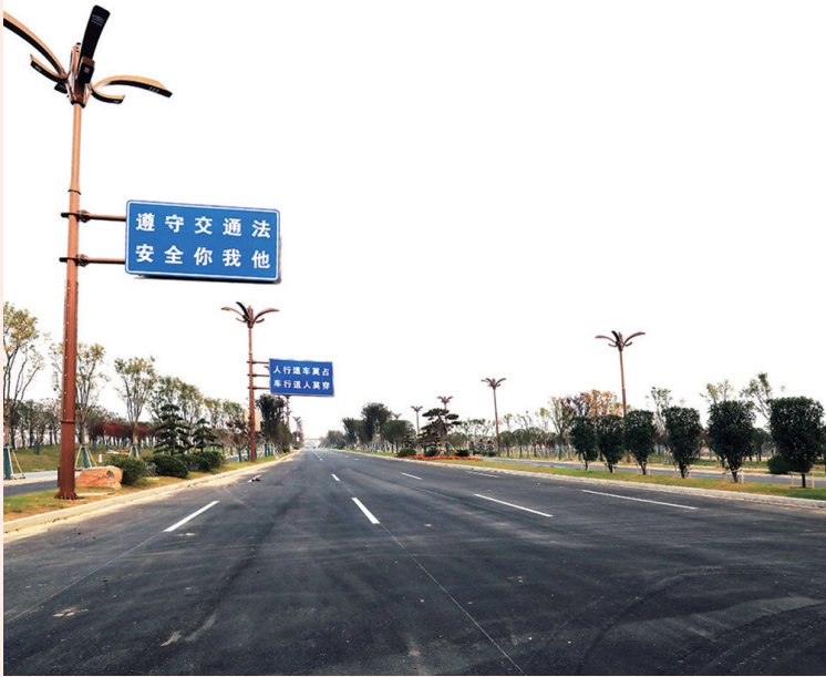
通湖东路延伸段将实现城市与高铁顺畅联通。目前该路段工程施工已全部完工,正在完善道路两边配套设施,本月底可通车。 图为新修建的六车道的通湖东路断面。
