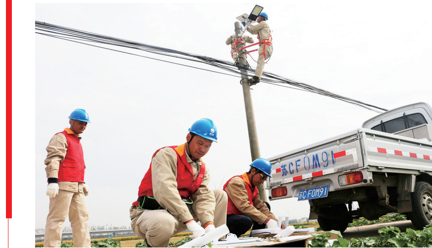
周山镇万福村长春组通往村口长约500米的小路一直没有路灯,居民夜晚出行极不方便。26日,市供电公司组织共产党员服务队赴该村组义务安装了11盏太阳能路灯,受到群众交口称赞。图为路灯安装现场。 林华鹏 陈名林 文正 摄影报道
