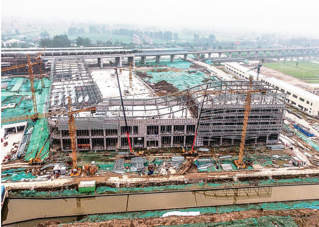
高邮高铁综合客运枢纽集高铁路站、长途客运站、城市公交首末站、农村公交站、出租车停靠站等为一体,目前项目土建工程已全部完成,眼下正在进行幕墙、暖通等施工,预计2020年10月前建成。图为施工现场。
