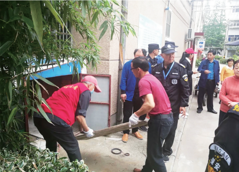
8日上午,南海社区会同公安、城管部门以及社区网格员、志愿者等,对辖区内小区居民楼旁的违建杂物间、违建防盗门等进行依法拆除,并及时完成建筑垃圾的清运工作。图为整治现场。 东方 摄
