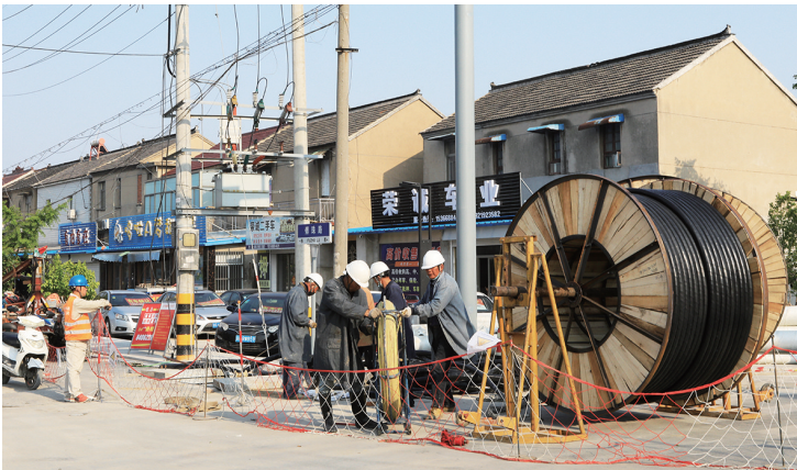
近年来,我市以文明城市创建为契机,对老城区基础设施进一步完善。图为供电单位正在傅珠路进行线路改造。王林山摄
