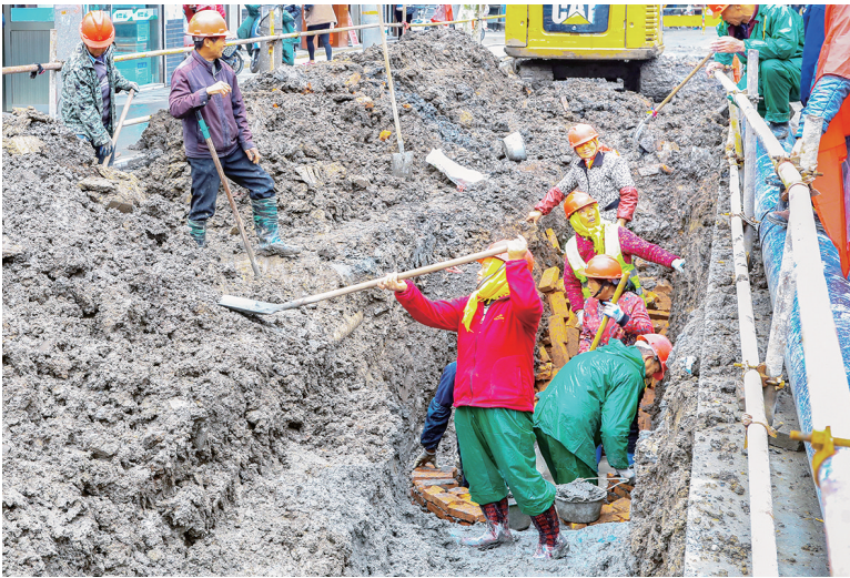
汪曾祺纪念馆正在有序建设中。连日来,市住建部门对其周边环境进行整治,其中除了对傅公桥路进行改造、增设环卫设施、对各类管线综合整治外,还将对建筑立面、店招店牌整治出新。图为施工单位正在更换傅公桥路下水管道。 王林山 摄
